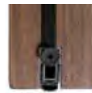
padající těsnění / padajúce tesnenie,
